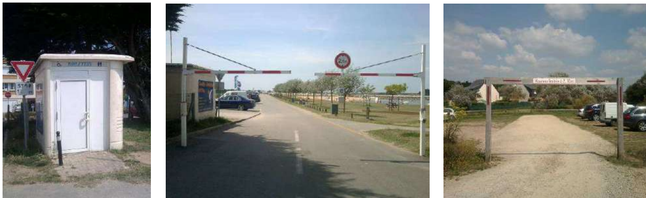
Figure 19 : Parkings de la plage du Stang et bloc sanitaire situé à proximité du parking nord - Source : IRH 2011
